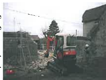
Travaux cour technique
