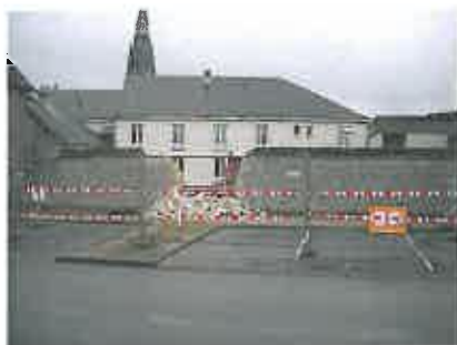
Travaux Mail ouest
